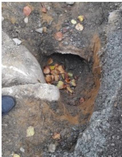
Der Gehsteig in der Lindenallee ist fertig, jedoch sind auch hier zusätzliche Arbeiten angefallen. Es gibt nun mehrere Straßenquerungen, um die Oberflächenentwässerung ordnungsgemäß zu gewährleisten. Bisher haben nämlich einige Verrohrungen nicht im Graben, sondern im Erdreich
